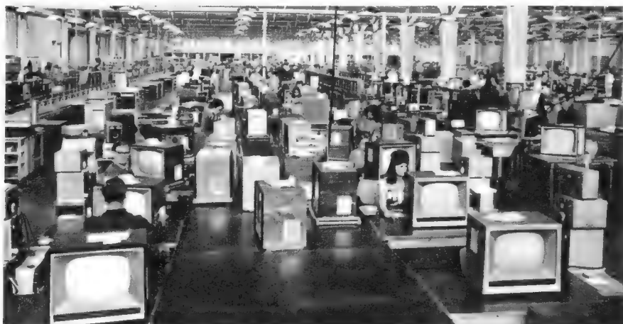
Bild 1. Blick in die große Montagehalle in Staßfurt mit einer Jahreskapazität von z. Z. fast 300 000 Geräten
